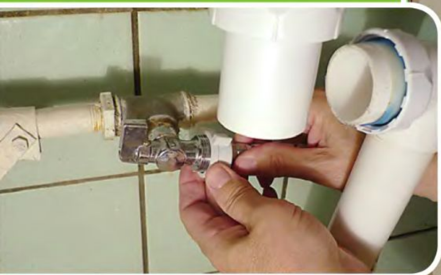
Подключение стиральной машины
